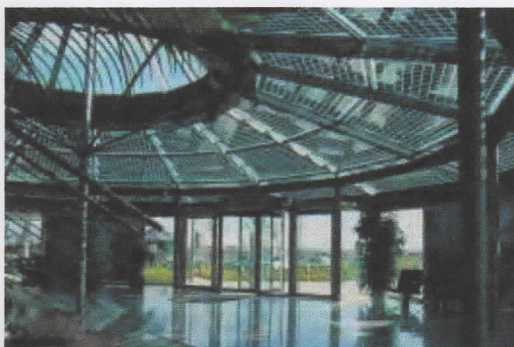
Διαφανή φωτοβολταϊκά σε στέγη κατοικίας επιτρέπουν τη διέλευση του φυσικού φωτός
