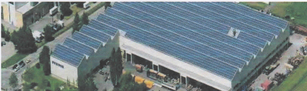
Εφαρμογες φωτοβολταϊκών σε ταράτσες κτιρίων
