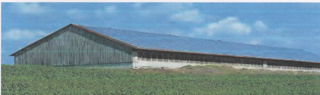
Ενσωμάτωση φωτοβολταϊκών σε βιομηχανική στέγη
