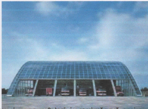
Ενσωμάτωση φωτοβολταϊκών σε γήπεδο ποδοσφαίρου
